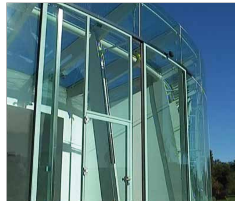
Automatisches halbrundes Glasschiebetor mit einer Gehtür Automatic glazed curved sliding door with a personnel door
