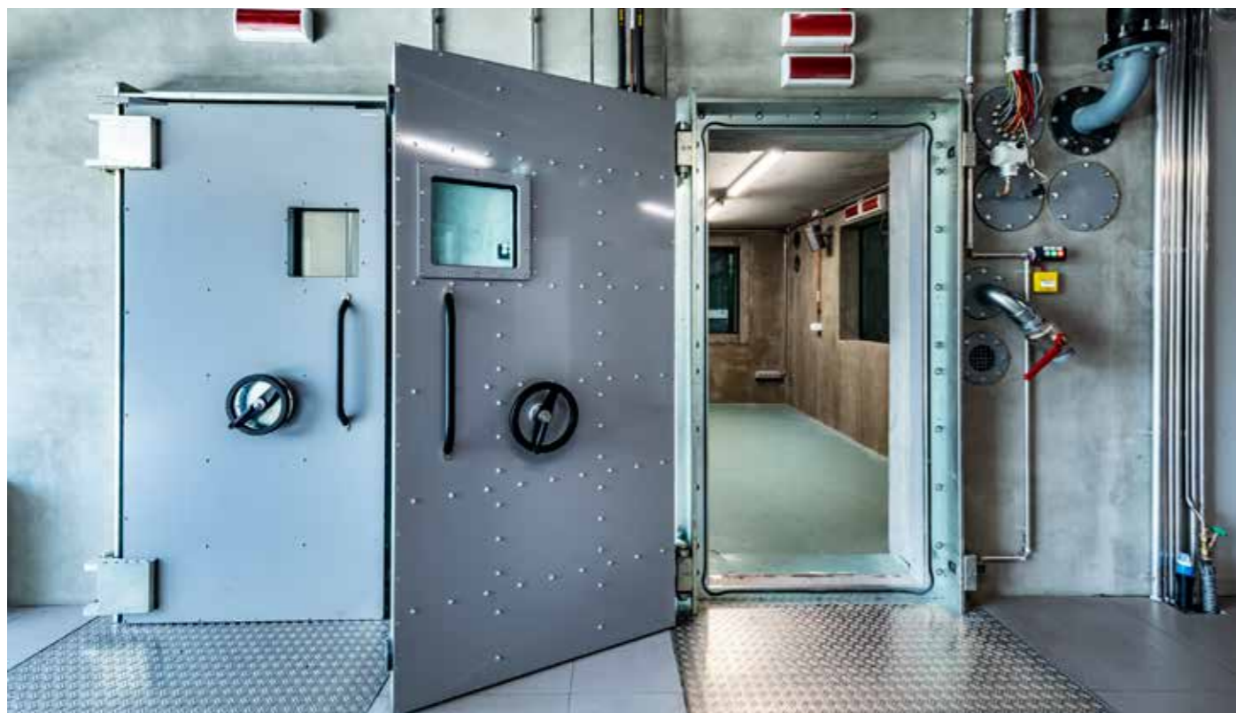
Unterdrucktore ausgelegt für bis zu 0.7 bar Vacuum gates designed for up to 0.7 bar
