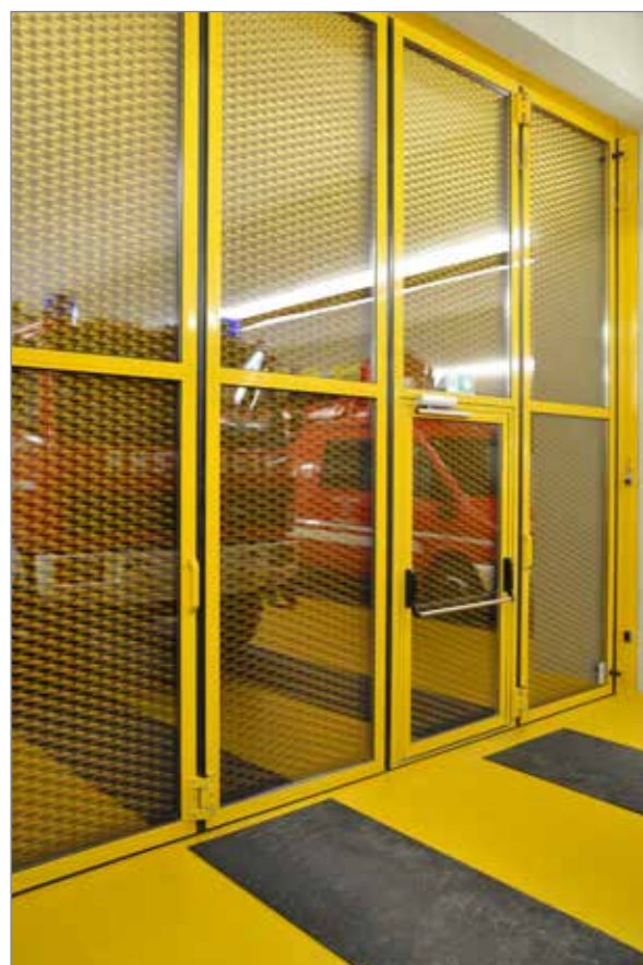
Feuerwehr Sand in Taufers, Falttore mit Isolierverglasung und außen angebrachter Streckmetallverkleidung Fire fighting station in South Tyrol, Bi-Folding Doors with tempered glass cladding and stretched metall facade
