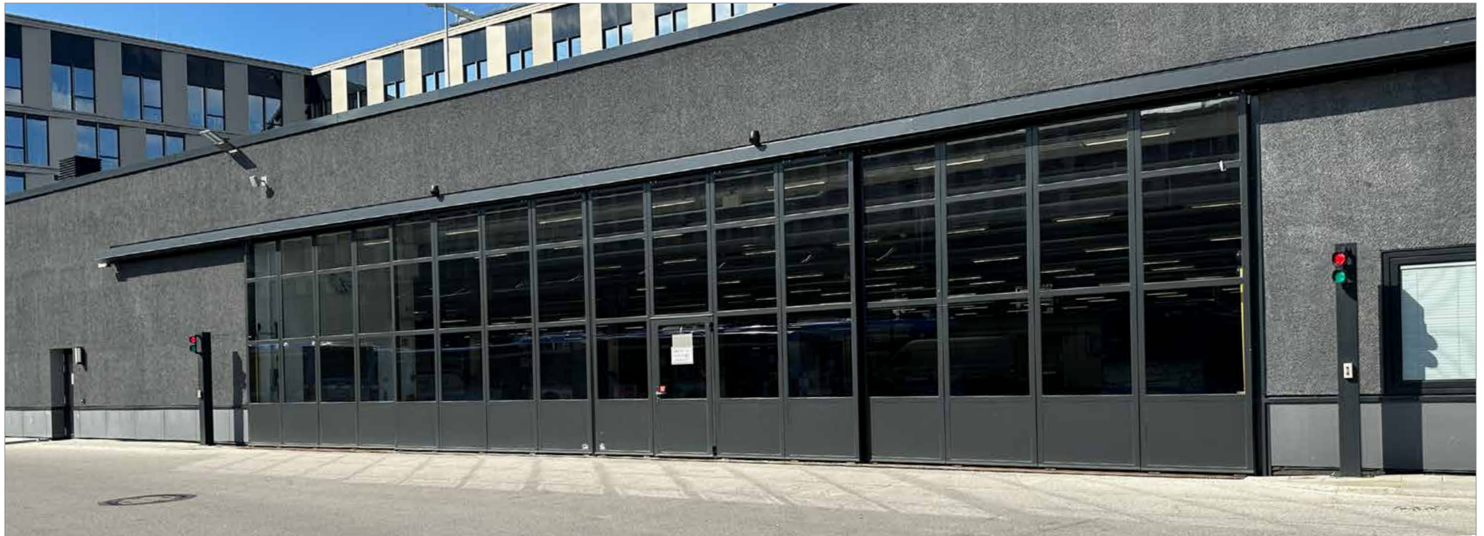
Teleskopschiebetor 20m x 4,5m Telescopic sliding door 20m x 4.5m
