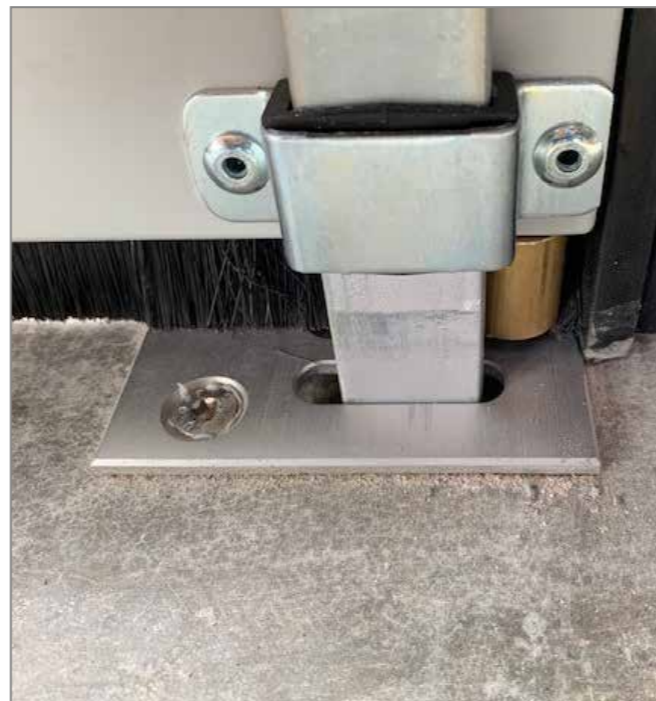
Bremslüftung für manuelle Betätigung - Treibriegel Break release for manual operation - Interlocking bar
