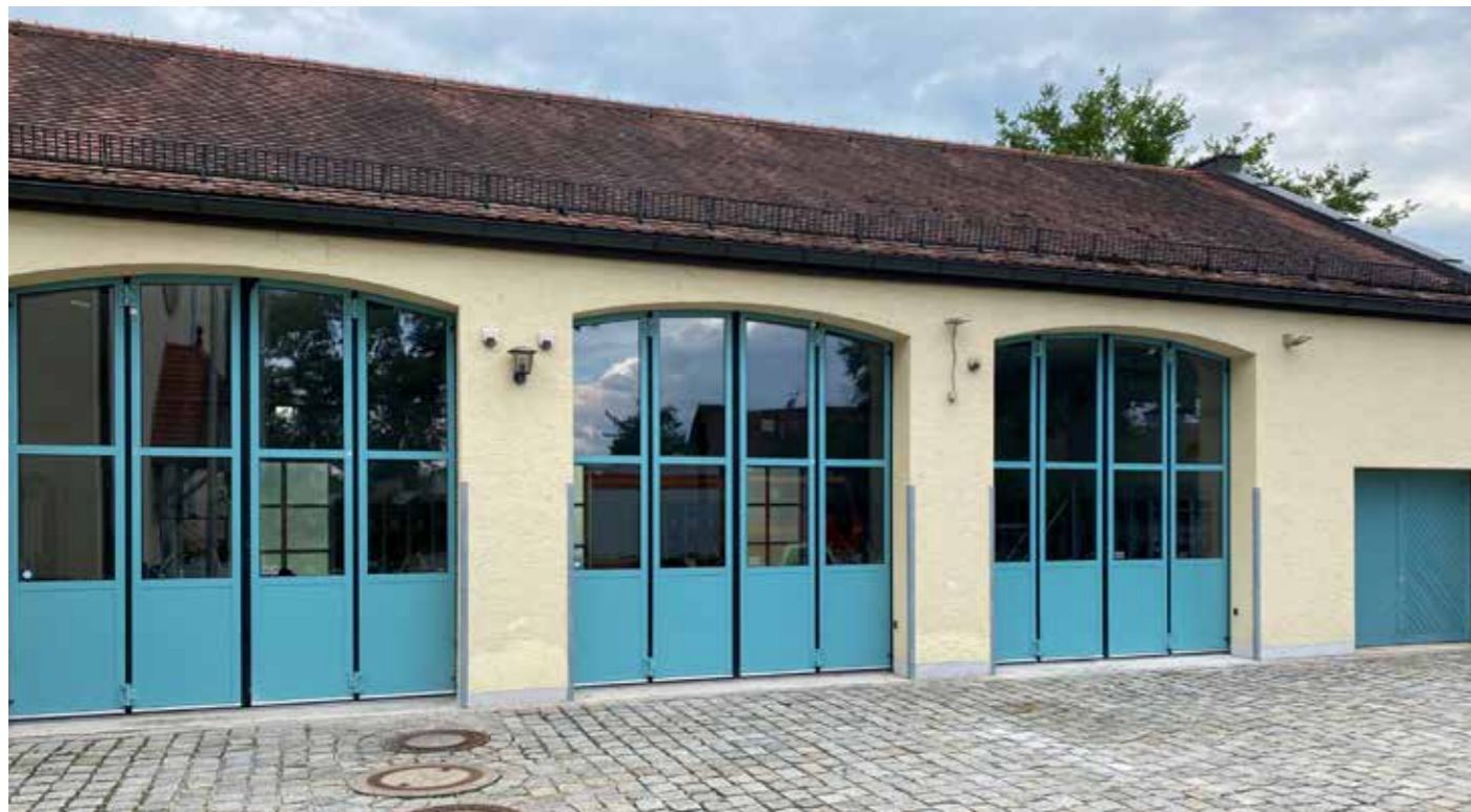
Denkmalschutzttore. Original nachgebaut. Monument protection gates. Original replica.
