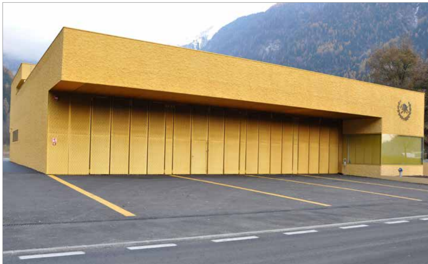
Feuerwehr Sand in Taufers, Falttore mit Isolierverglasung und außen angebrachter Streckmetallverkleidung Fire fighting station in South Tyrol, Bi-Folding Doors with tempered glass cladding and stretched metall facade
